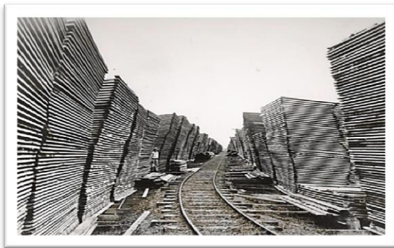
Figura 32 – Visão em perspectiva formada pelo empilhamento de madeira ao redor dos trilhos dos vagonetes. Uma técnica para facilitar a secagem da madeira serrada. Foto de Claro Jansson.
