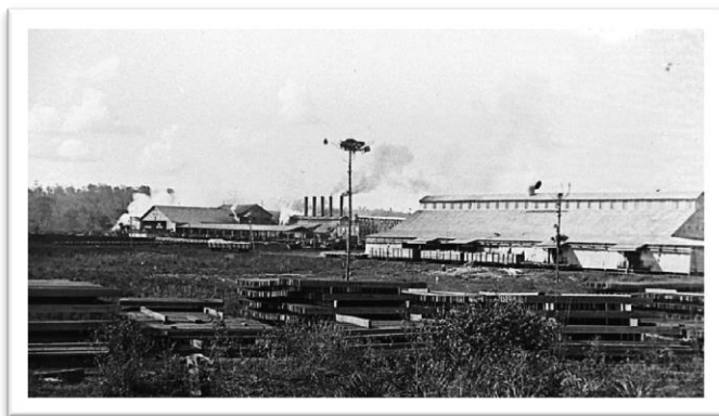
Figura 17 - Vista das instalações da serraria Lumber. Foto de Claro Jansson.
